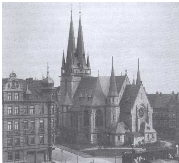
Abb. 1: Originaler Zustand der Lutherkirche. Ansicht von Südwesten, ca.1902 (PA-Lut: Photobestand).
