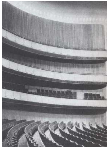
Abb. 16: Zuschauerraum nach dem Wiederaufbau durch W.Kallmorgen, 1950 (HistMus-H: Bildarchiv).
