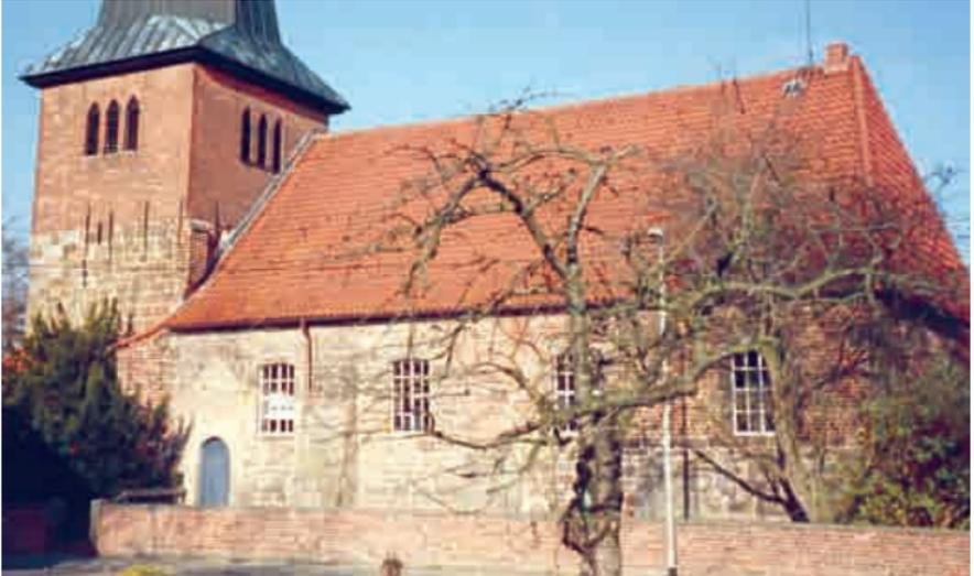
I) Saalbau aus Mischmauerwerk mit rechteckigem Ostschluss und deutlich aus der Achse nach Süden verschobenem Westturm.
