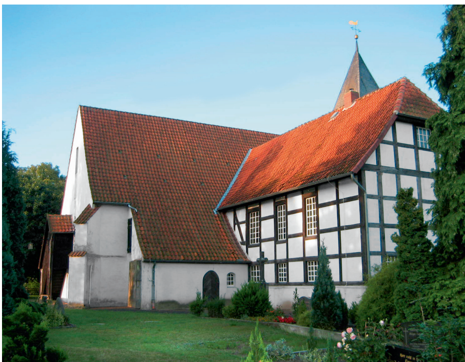
1 Steyerberg-Rießen, Ldkr. Nienburg, St. Katharinen-Kirche, Ansicht von Nordosten, August 2006.
