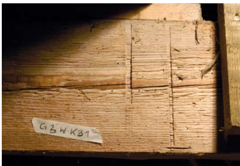
Abb. 12: Westgiebel des Saales mit auf den Binderbalken des Gespärres Nr. 1 aufgestellter Wandvorlage; 01/08.
