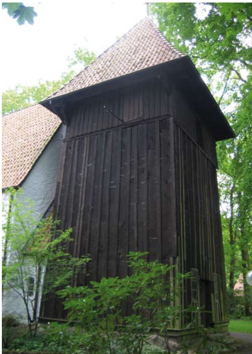
Abb. 2: Ansicht des Glockenturmes von Nordwesten; 05/08.
