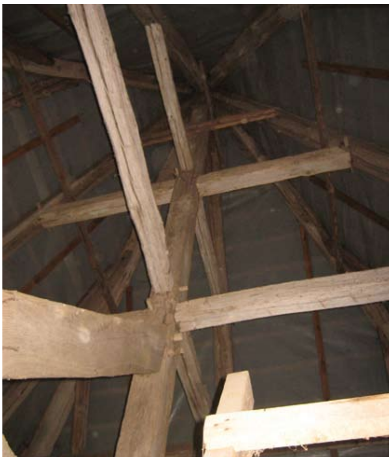
Abb. 22: Blick von unten in das Dachwerk des Glocken- turmes; 05/08.
