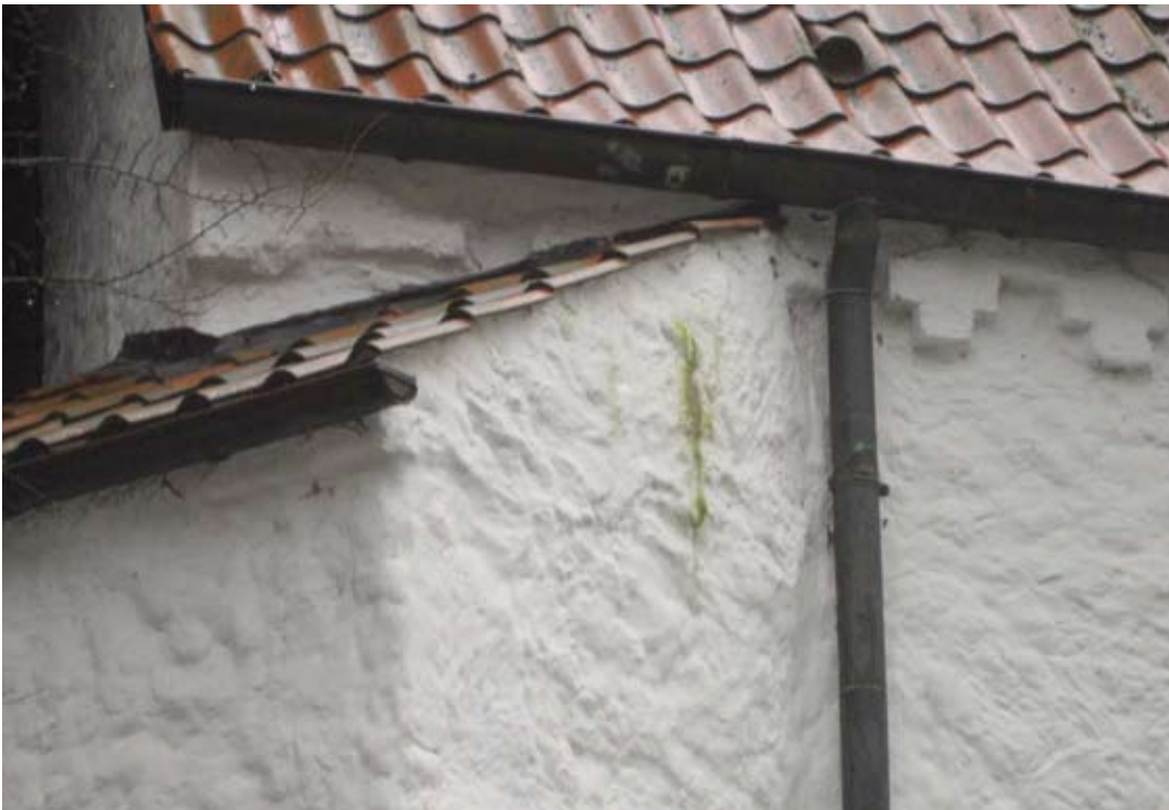
Abb. 24: Oberer Ansatz des südwestlichen Stütz- pfeilers; 05/08.
