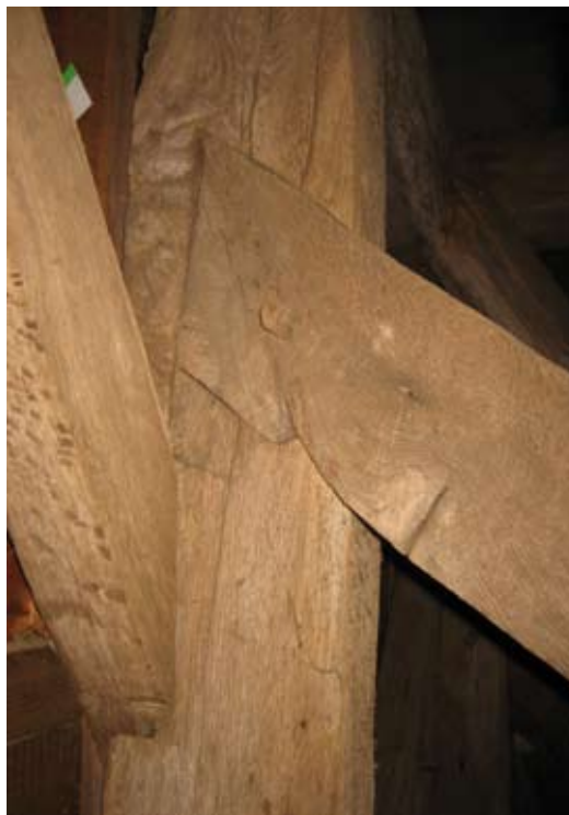
Abb. 20: Kreuzungspunkt der doppelten Andreaskreuz in der Ebene der südlichen Turmwand; 05/08.
