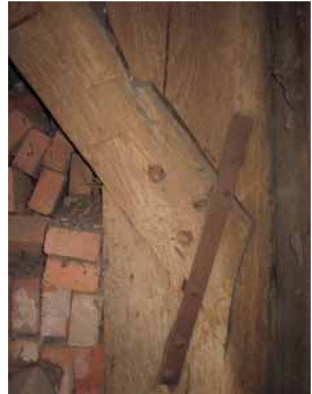
3 Anschluß einer Diagonalstrebe an den südöstlichen Eckständer: geschlossene Verblattung, ausgeführt als Hakenblatt mit schräger Brust und geschweiften Stirn.
