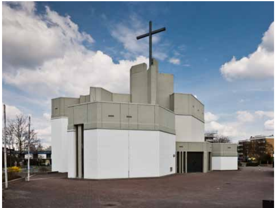
1 Ansicht der Kirche von Südwesten, heutiger Zustand
