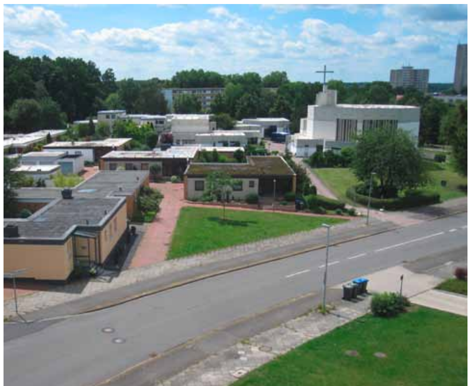
2 Ansicht der Gesamtanlage von Osten, heutiger Zustand
