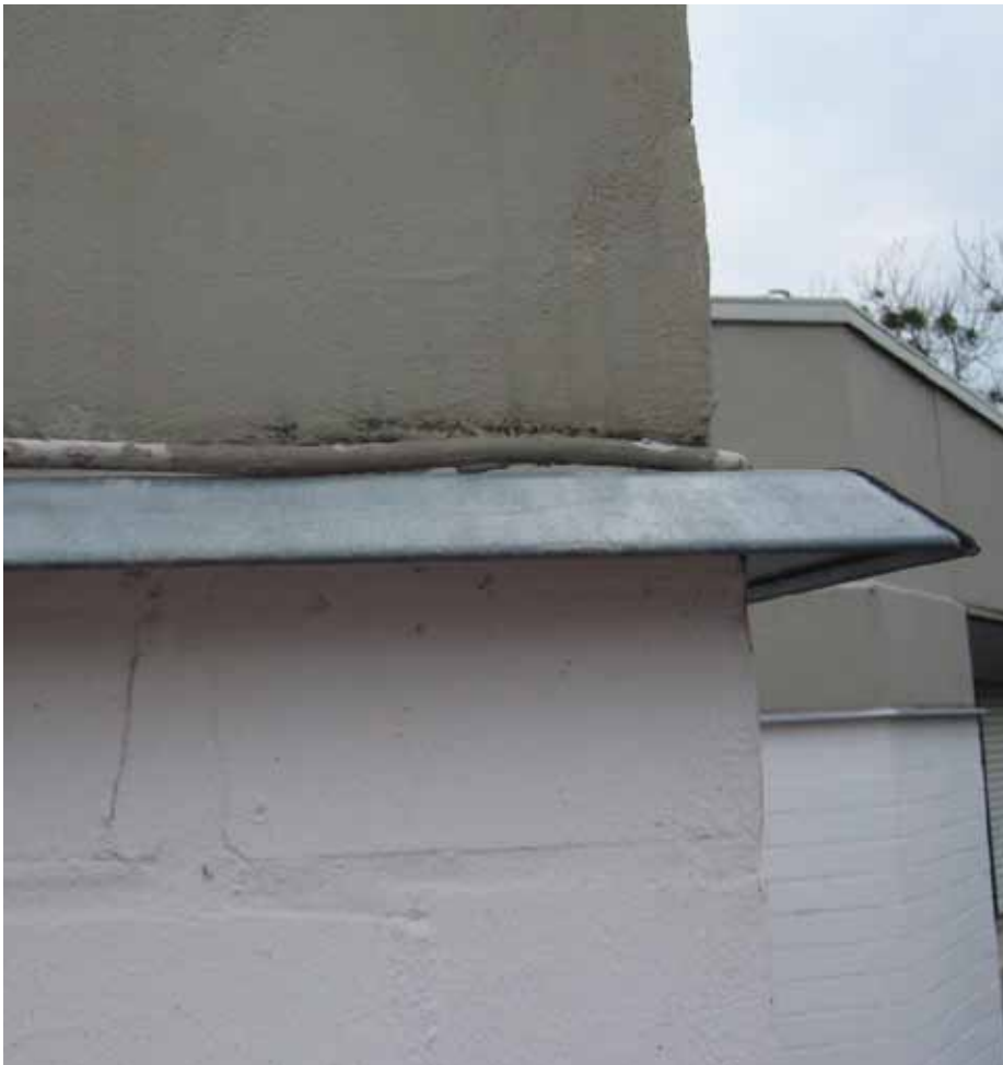
12 Detailansicht der an allen Gebäuden eingerichteten Tropfkante
