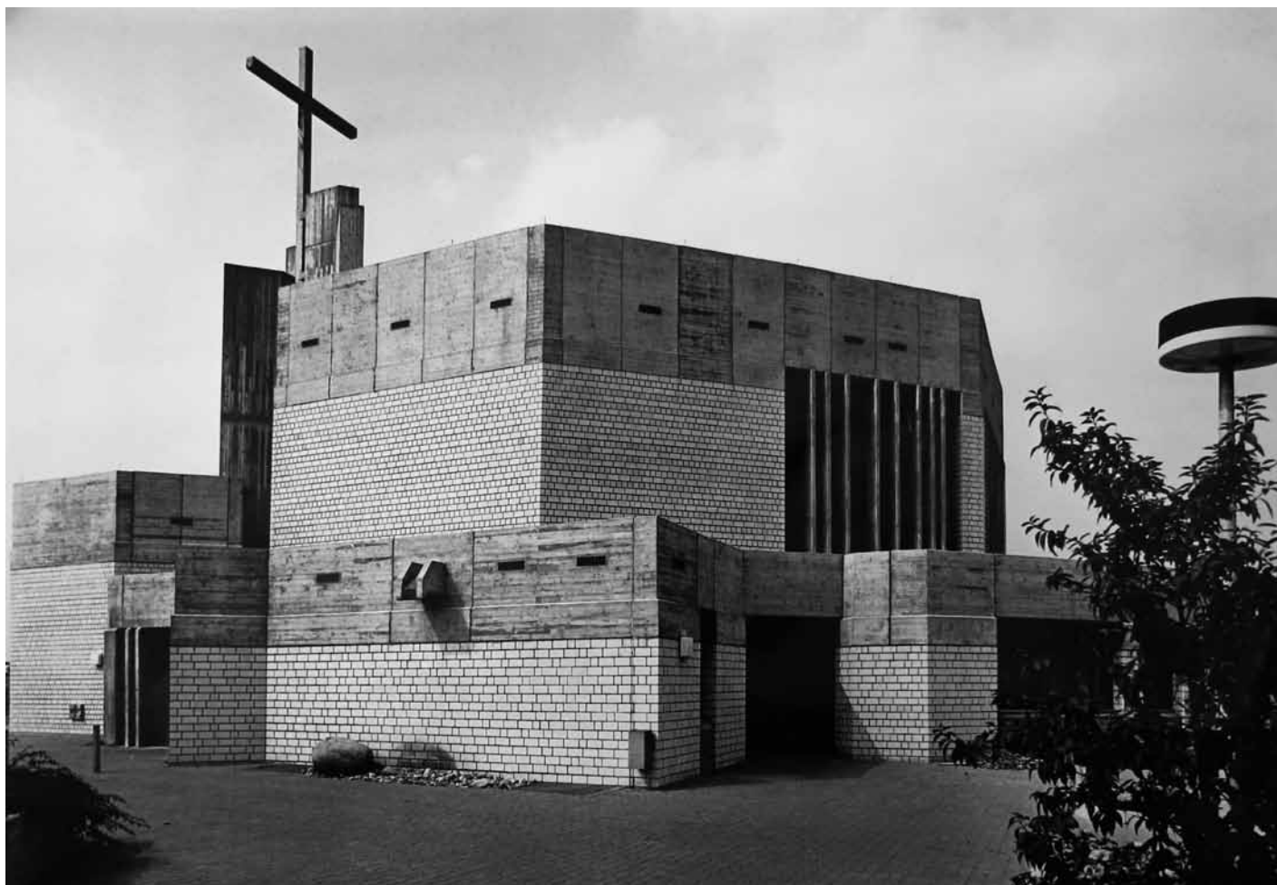
11 Ansicht der Kirche nach Fertigstellung, Blick von Südosten
