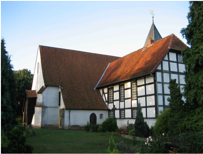
Abb.1: Steyerberg/Rießen: Ansicht von Nordosten, Aug.2006.
