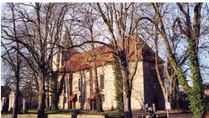
Abb.6: Nendorf: Ansicht von Südosten, März 2003.
