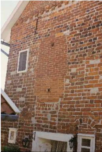
In der Südwand der Kirche ist ein ähnlicher Befund fassbar. Verdeckt von dem hölzernen Emporenaufgang ist unterhalb des ursprünglichen Fensters der ersten westlichen Achse in der Südwand eine vermauerte Öffnung zu erkennen. Aufgrund ihrer Dimensionierung ist diese nicht als Fenster, sondern als Durchgang zu deuten.
