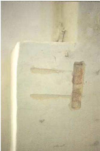
Festzustellen war die Einbindung eines Backsteins in das westlich anschließende Mauerwerk.
